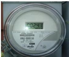
**Compteur non communicant** : c'est un compteur numérique de marque Itron qui est identifié par un X au début du numéro de série (ex. X9SJ - 000 130). Il émet de l'électricité sale et il a la capacité de facturer selon l'heure d'utilisation (ex. 0,18 \$ le kilowatt lors de l'heure de pointe versus 0,08 \$ hors l'heure de pointe) : comptabilise la quantité de kilowatts consommée et l'heure de la consommation.
