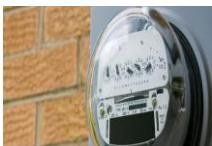
**Compteur électromécanique à radiofréquences** : Il semble électromécanique dans la moitié du haut, mais la moitié du bas a un grand rectangle noir. Le relevé prend la lecture à distance ; quand le compteur n'est pas accessible, vous ne recevez jamais une carte pour communiquer à HQ la lecture et dans votre facture vous ne recevez pas des montants estimés. Il émet des radiofréquences.
